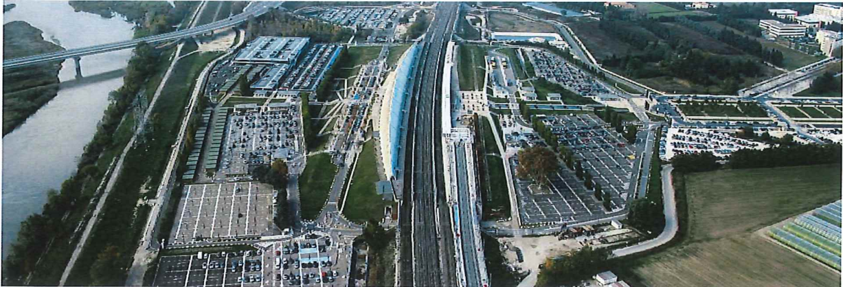
Site Courtine – Gare TGV
